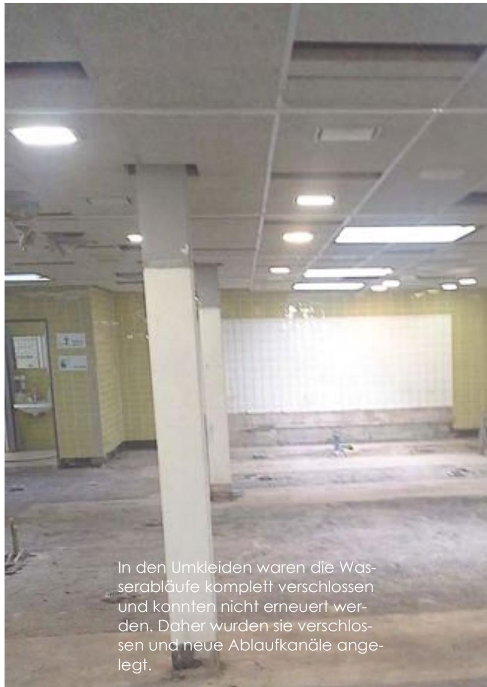
In den Umkleiden waren die Wasserabläufe komplett verschlossen und konnten nicht erneuert werden. Daher wurden sie verschlossen und neue Ablaufkanäle angelegt.
